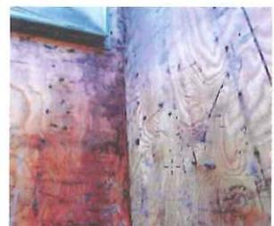
外壁内部の雨漏りの跡
